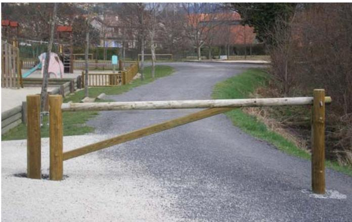
**barrière pivotante** (verrouillable par cadenas d'artillerie)
